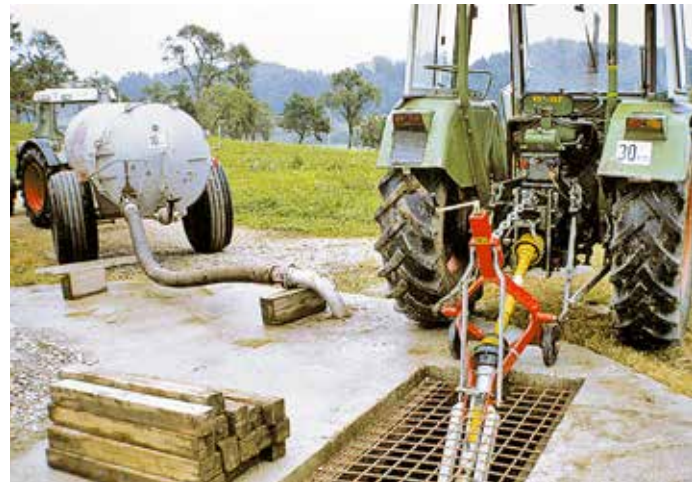
Grube mit fixem Ansaugrohr und Schutzgitter für Güllemixer
