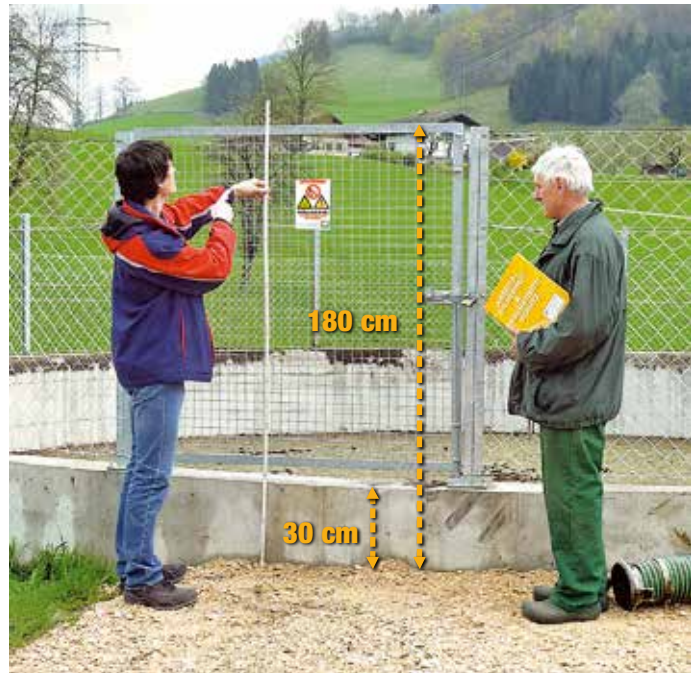
Offene Güllegrube mit 1,8 m hoher Umzäunung, Anfahrtschutz, Vorhängeschloss und Warntafel.
