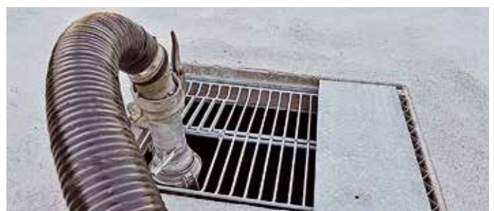
Mehrteiliger Deckel mit Saugrohr- bzw. Rühröffnung und Entlüftungsschlitzen
