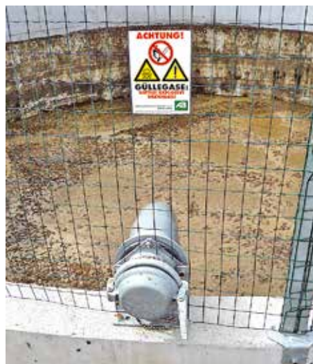
Grube mit fest montiertem Ansaugrohr und Warntafel
