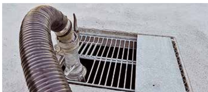
Mehrteiliger Deckel mit Saugrohr- bzw. Rühröffnung und Entlüftungsschlitzen
